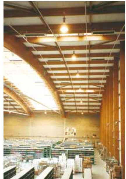
Los paneles radiantes son especialmente rentables en los edificios de techos altos, pues evitan las pérdidas de calor entre el panel y el suelo.
