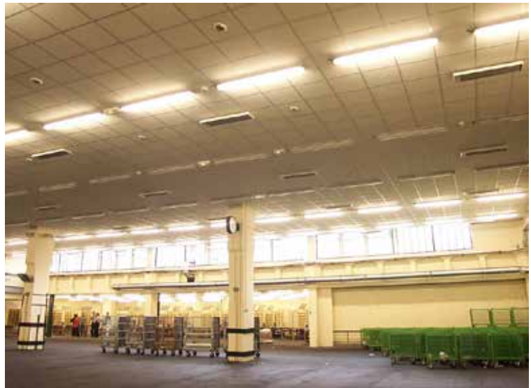
Los paneles radiantes dirigen el calor hacia las personas, el suelo y el mobiliario, proporcionando un alto grado de confort incluso en estancias muy grandes.
