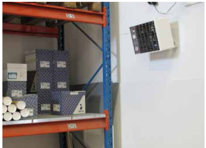
Cat dispone de un soporte para montaje en pared que le da una inclinación de 10°, ideal para una buena distribución del calor.
