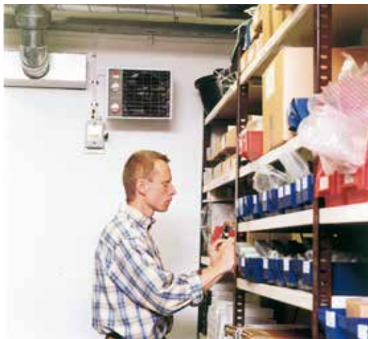
Los recintos que se usan poco se pueden calentar rápidamente cuando es necesario con un aerothermo.
