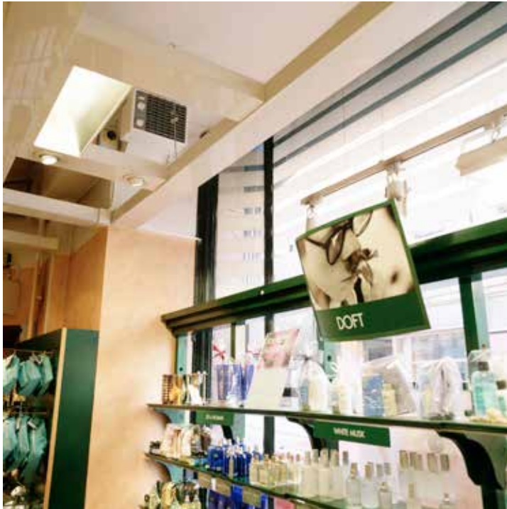
El aerothermo Cat con cámara de mezcla resuelve fácilmente los problemas que plantean los recintos con presión negativa. El aparato absorbe aire frío por la parte inferior, lo calienta y lo expulsa a la estancia.
